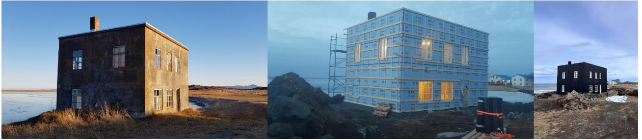
Mynd 4: Gamla fundarhúsið í Kelduhverfi (Vogar) – Fyrir klæðningu, á meðan á henni stóð og lokaniðurstaða. Myndir: Bjarni Jónsson
