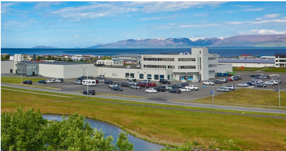
Starfsstöð AVS sjóðsins hjá Byggðastofnun.
